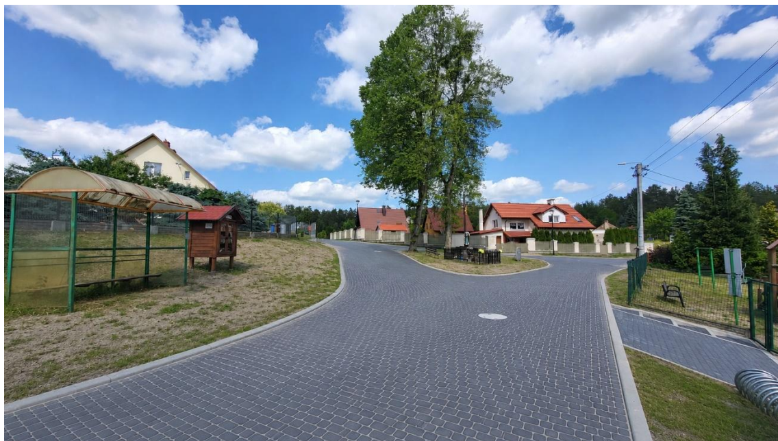
Zdjęcie 2 Inwestycja drogowa w miejscowości Cis
